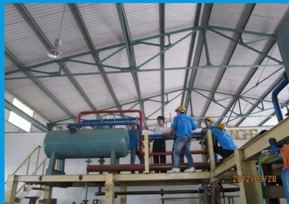
Lắp đặt ống
