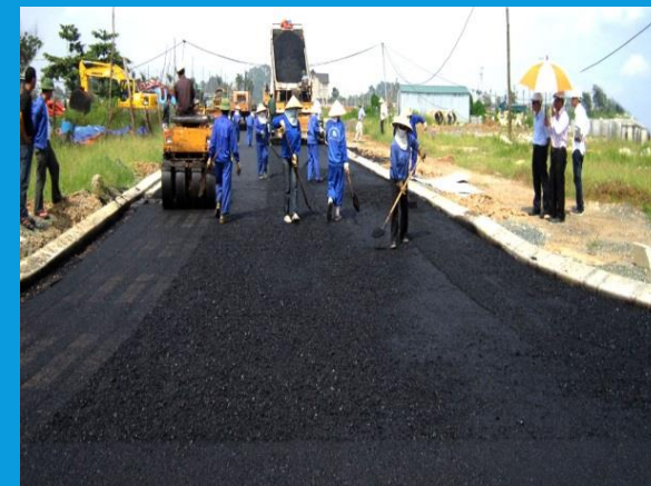
道路・橋梁工事
